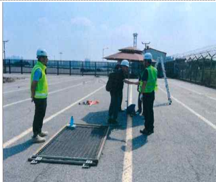
공사명 내항5부두 해경부지 뎀스 철거 및 운항철조망 설치공사 내 용 공사현장 점검 일 시 2023.08.14.
